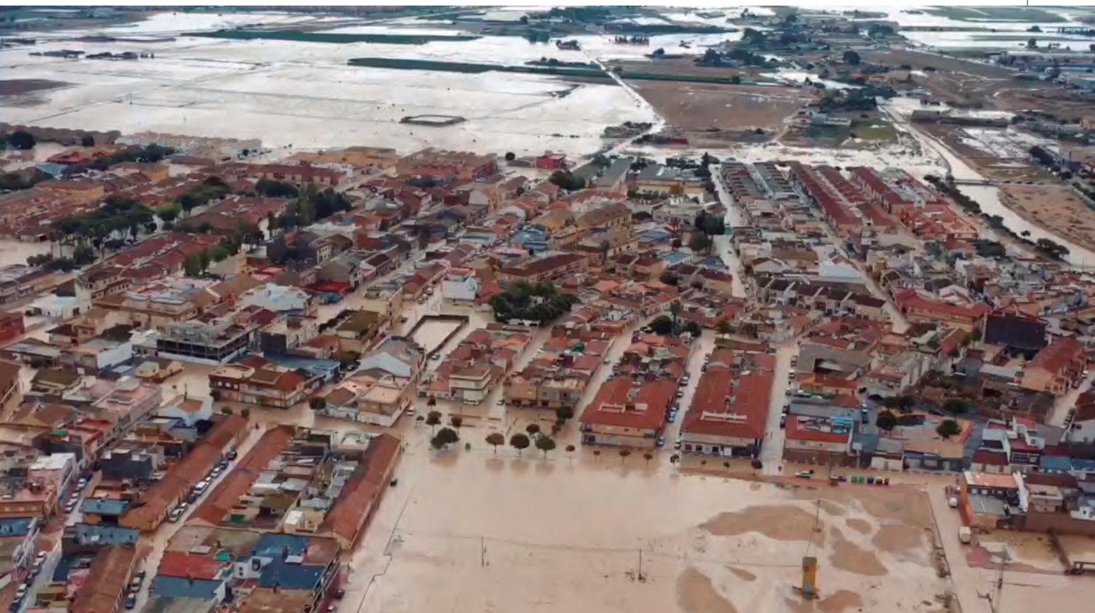
Inundación en Torre Pacheco (Murcia) el pasado mes de septiembre. Fuente: Ayuntamiento de Torre Pacheco
