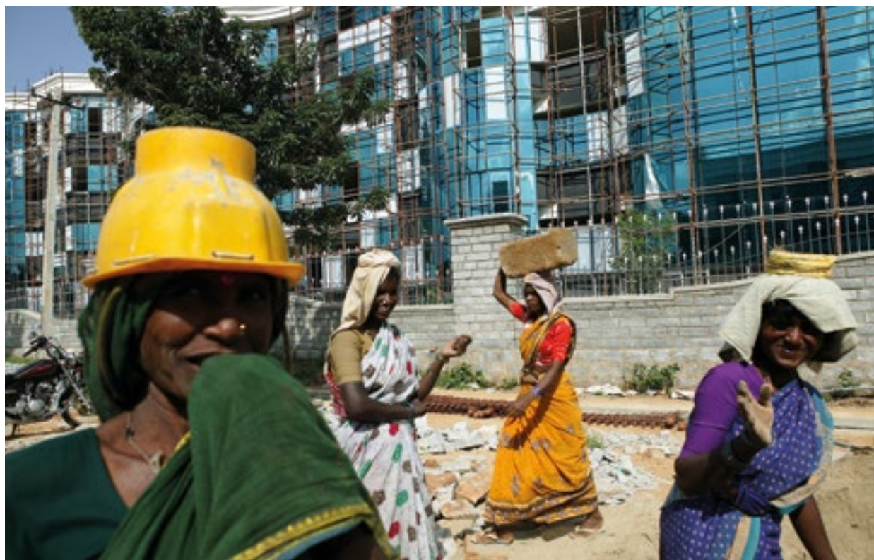
Un grupo de obreras trabaja en la construcción de oficinas para empresas informáticas en un nuevo parque tecnológico, en Bangalore, la India (2004). Foto: Panos/Fernando Moleres
