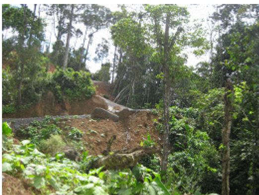
Carretera de acceso a área de reubicación Valle Rey
