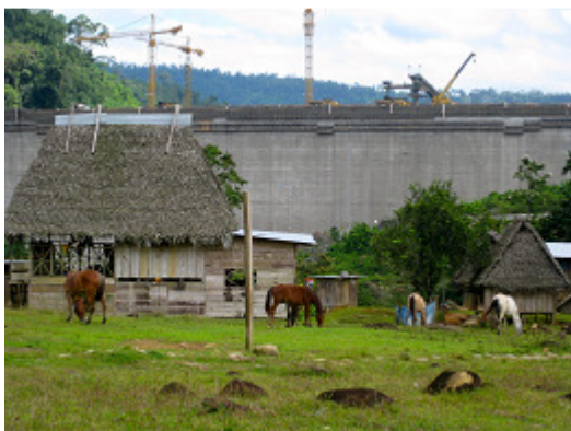
Construcción del muro de la presa Charco de la Pava
